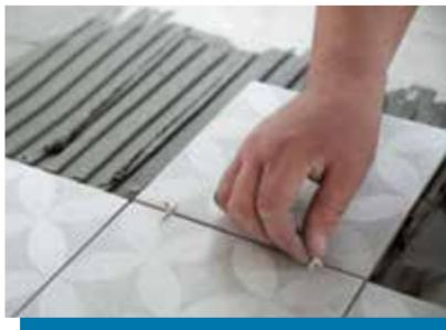
Para obtener una mejor terminación del enchape se ha colocado como junta entre piezas un sello de fragua que no cumple fines de unión (no sostiene el cerámico).
