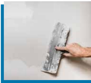
En caso que las fisuras se produzcan en paredes enchapadas, en estos casos es recomendable retirar las piezas afectadas, tratar las fisuras de la misma forma que las especificadas en el párrafo anterior (aplicando un material elástico), y reemplazar el enchape por piezas nuevas.
